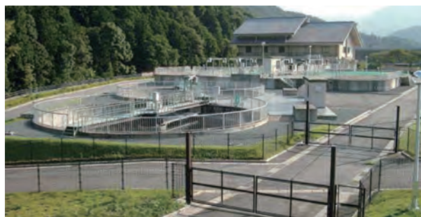
いすずがわなかむらじょうか 五十鈴川中村浄化センター(中村町) 1日最大処理水量 3,200m 3 /日
