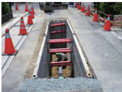
下水道管を埋める様子
