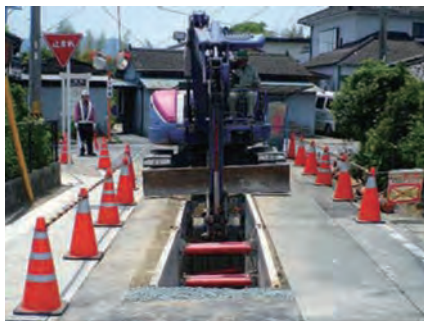
下水道管を埋める穴を掘っている様子
