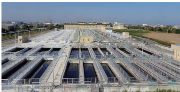
みやがわじょうか 宮川浄化センター(大湊町) 1日最大処理水量 75,600m 3 /日(全体計画)
