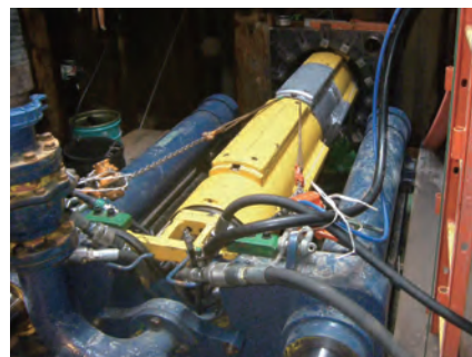
機械で横穴を掘っている様子 (地下深くに下水道管を埋める工事)
